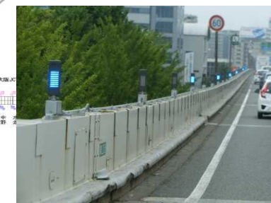
速度回復誘導灯設置状況 （13号東大阪線森之宮付近）
