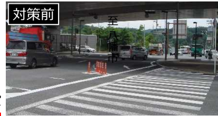
【写真】津田北町3交差点の対策状況
