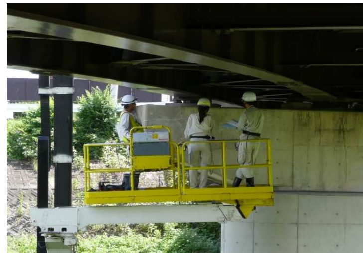
H27.8.27 茨木市 高田町豊川4丁目線 幣久良橋
