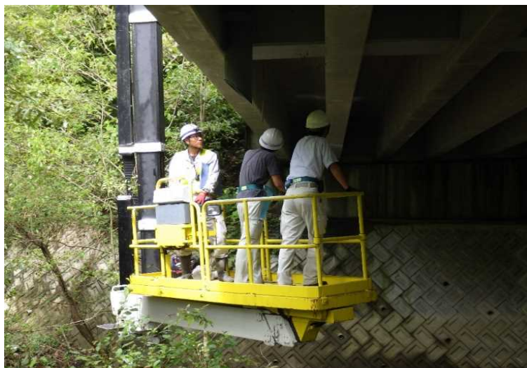
H27.8.21 泉南市 別所畦の谷山間線 池の谷橋
