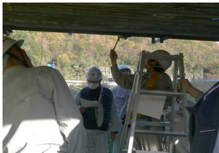
H27.11.20 豊能町 町道宮ノ下線 城山橋
