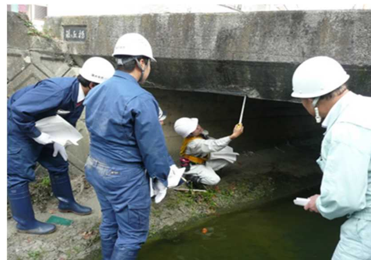
H27.11.6 藤井寺市 藤が丘2線 藤が丘橋
