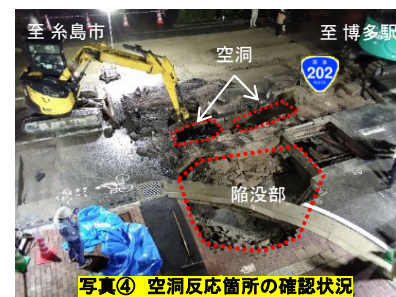
写真④ 空洞反応箇所の確認状況
