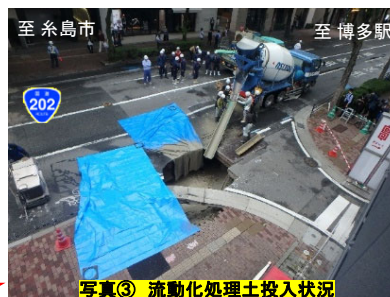
写真③ 流動化処理土投入状況
