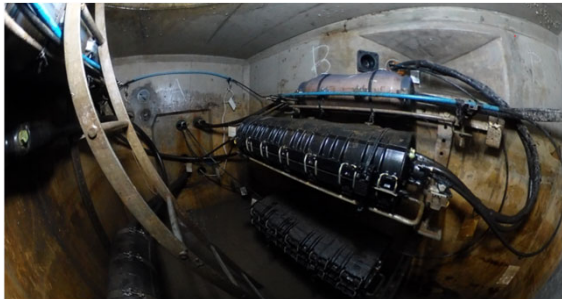
マンホール内写真
