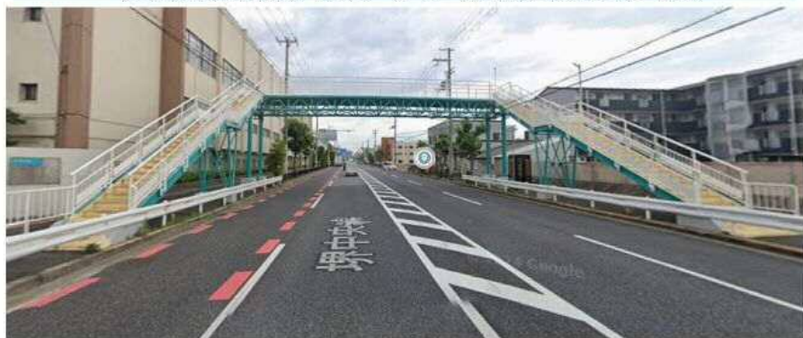
②5 対象施設 (株クボタ堺製造所歩道橋)
