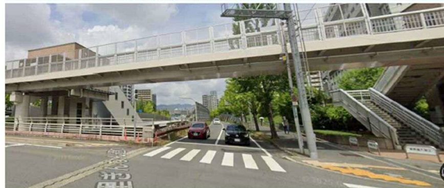
②2 対象施設 (桃山台駅連絡通路橋)
