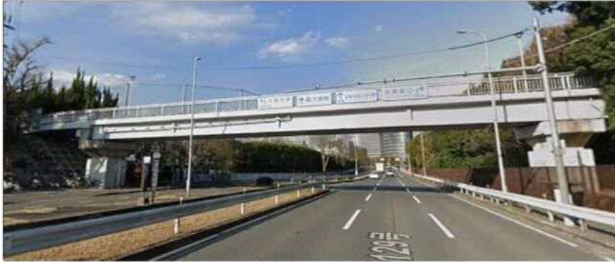
②9 対象施設 (1号橋 (北口))
