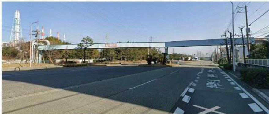
③③ 対象施設 (油送管橋)
