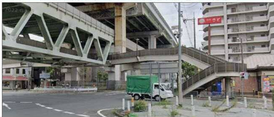
⑨ 対象施設 (吉田駅歩道橋 (上・起))
