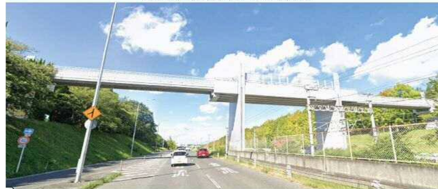
②6 対象施設 (松城橋)
