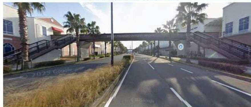
③8 対象施設 (歩道橋)
