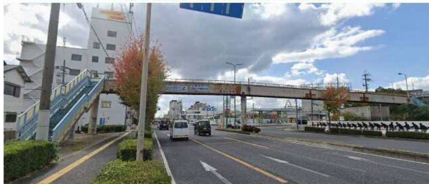
⑳ 対象施設 (臨海歩道橋)
