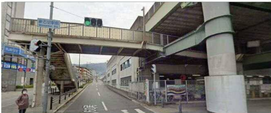
⑰ 対象施設 (新石切駅歩道橋 (上・終))
