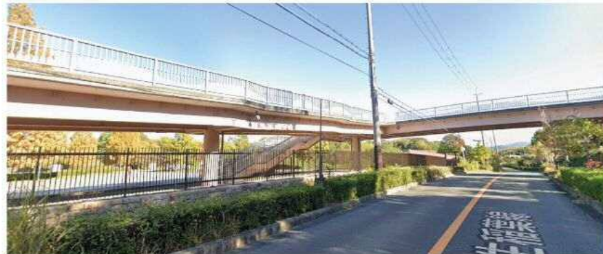
③④ 対象施設 (蜻蛉池橋 (公園連絡橋))
