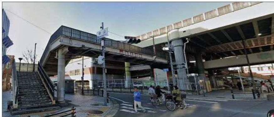
⑬ 対象施設 (新石切駅歩道橋 (下・中))
