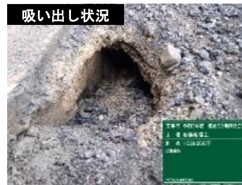
側溝補修状況
