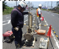
(貫入試験による調査)
