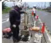
(貫入試験による調査)
