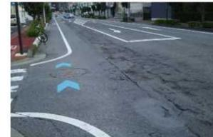
占用工事が起因する路面損傷
