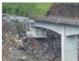
斜面変状による橋台の沈下
