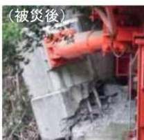
制震ダンパー取付部の損傷
