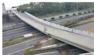
ロッキング橋脚を有する橋の落橋
