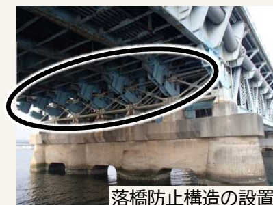
落橋防止構造の設置
