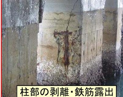
柱部の剥離・鉄筋露出
