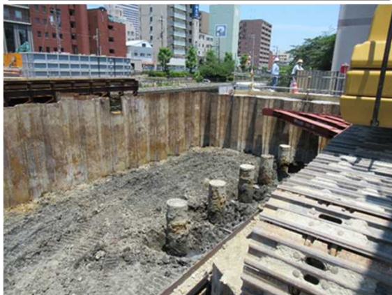
①橋台部分の土砂を掘削
