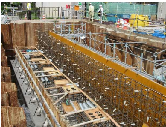
②鉄筋・型枠の設置
