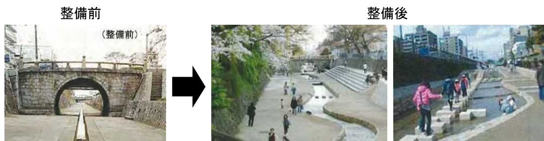
堀川のせせらぎ水路の整備
