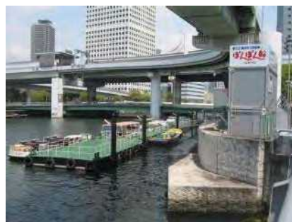
ポンポン船船着場
