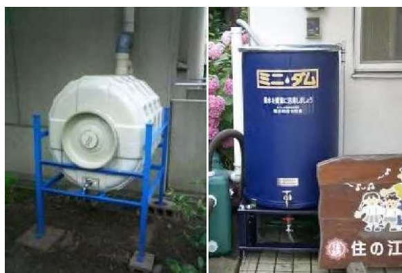
雨水タンクの設置例
