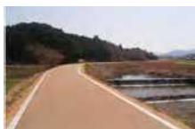
奈良県宇陀川の遊歩道整備
