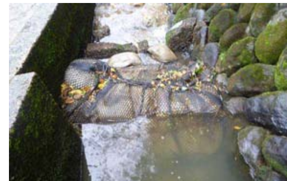
下流側隔壁間土のう(流失なし)
