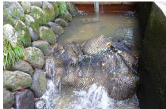
上流側隔壁間土のう(流失なし)
