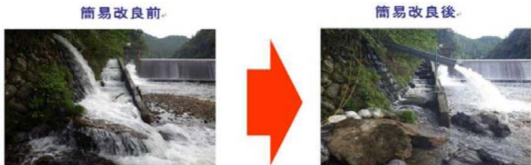
宇陀川における魚道の簡易改良による連続性の確保(魚道流量の調整、隔壁補修、落差緩和)
