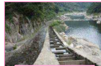
大河原発電所取水井堰
