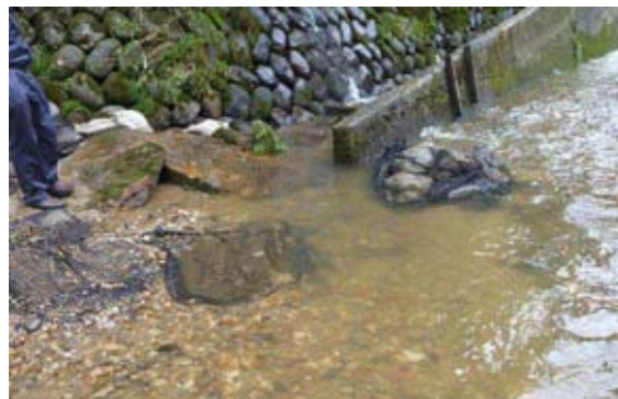
魚道入り口部土のう(流失なし)
