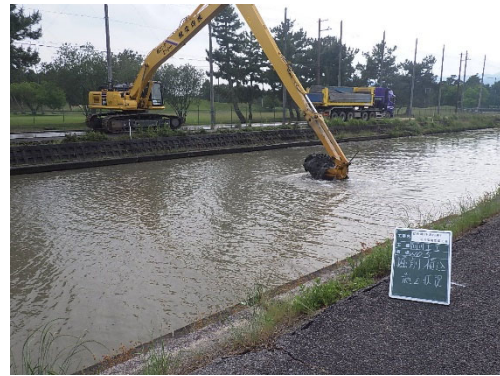
底泥浚渫による水質浄化（木浜内湖）
