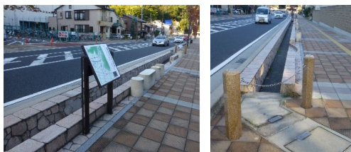
長等地区せせらぎ水路
