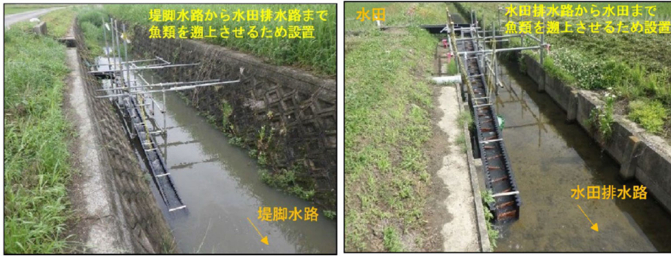
簡易魚道 水田魚道 水田魚道実験施設の設置状況（新居遊水地内堤脚水路）
