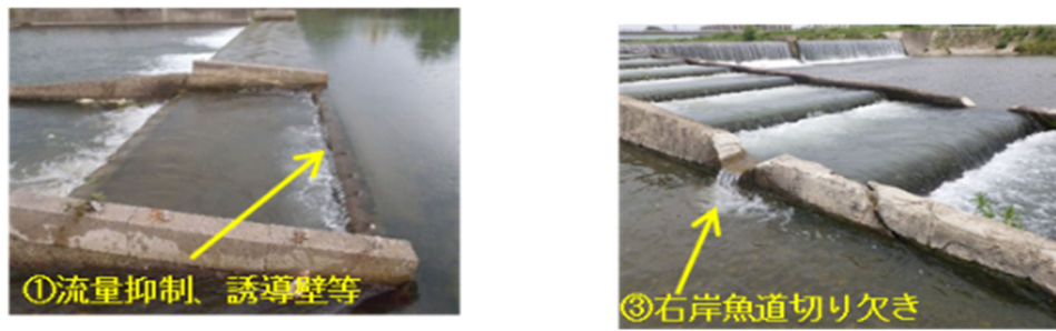
桂川3号井堰の改良例
