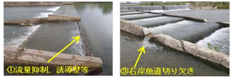
桂川3号井堰の改良例
