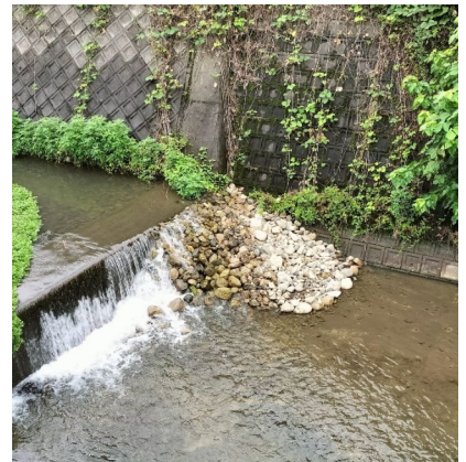
小わざ魚道状石積み
