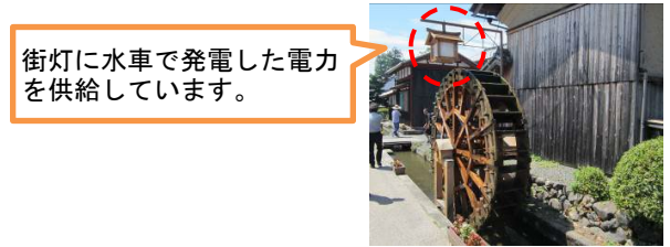
農業用水を利用した小水力発電
