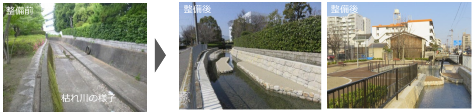
導水事業及び三条坊町公園親水拠点の整備
