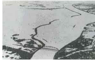
写真2-2-1 昭和28年台風13号によって宇治川左岸の向島堤が決壊
