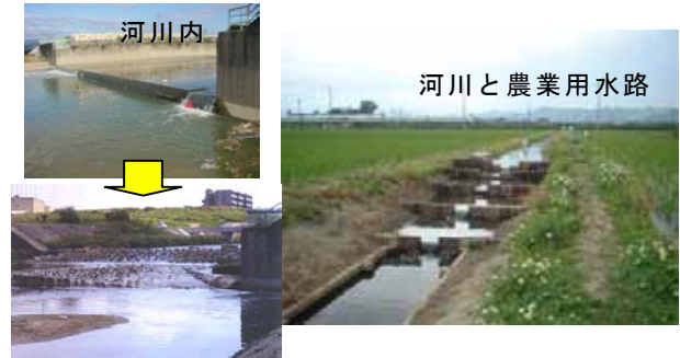
魚道の整備 ＜河川内の連続性確保のイメージ＞
