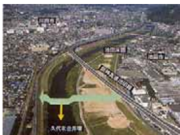
写真 1-2-2 河川の横断方向の連続性分断 (水域～高水敷・堤防～河川区域外)
