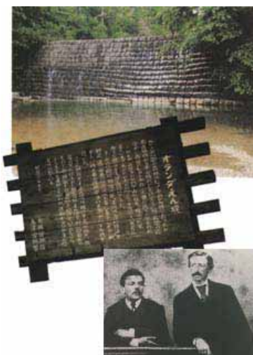
写真 3-1-4 オランダ堰堤
