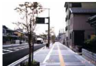
<透水性舗装の歩道>
