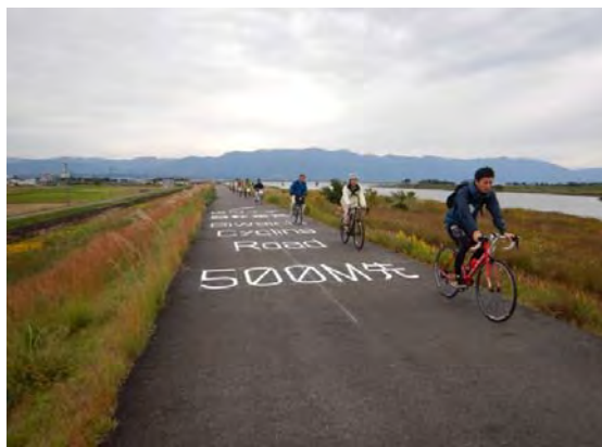
堤防天端の様子
