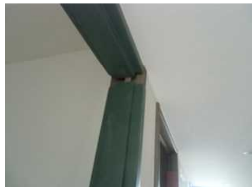
木製建具枠養生(規格形状用)
