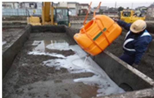
液体固化材 投入状況
