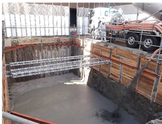
流動化処理土打設状況
