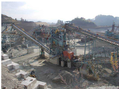
プラントの様子
