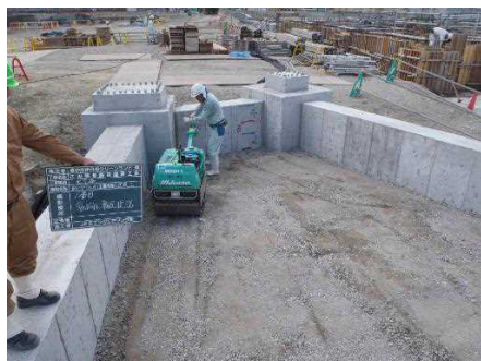
再生砕石による埋め戻し
