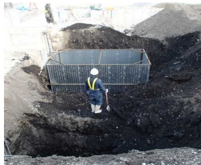
キーストン型枠による施工
