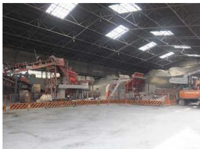
再生砕石、再生砂プラント
