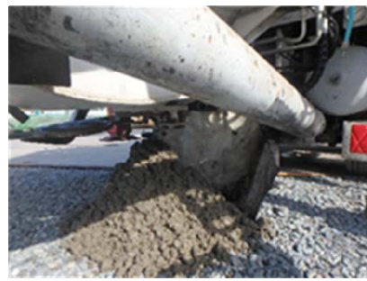
打設時に発生する余剰コンクリートに「改良剤」添加・固化後、適宜作業ヤードの砕石として使用
