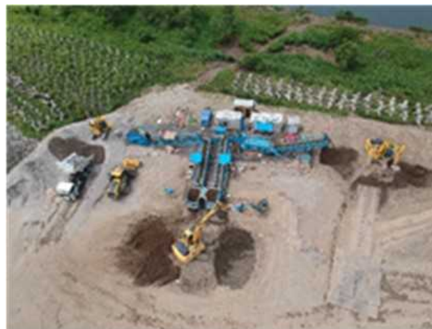
「万能土質改良機システム」を活用し土砂混合施工
