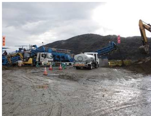
土砂混合施工状況(雨の日)
