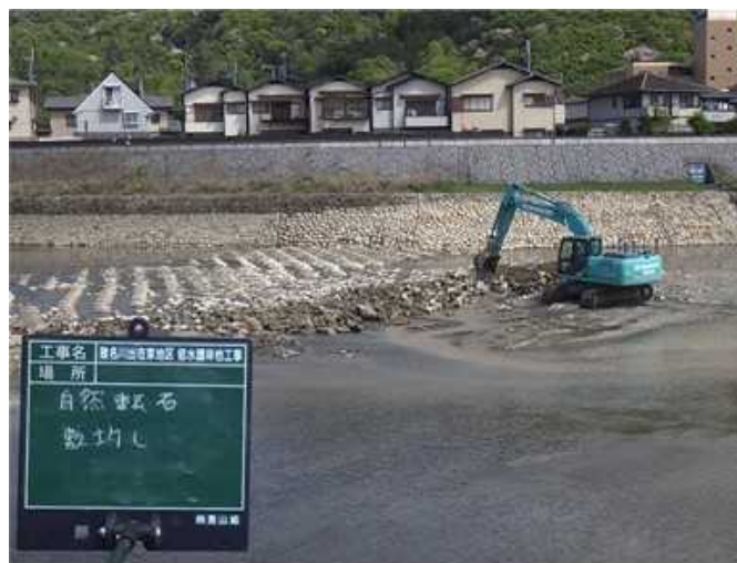
自然石敷均し 状況
