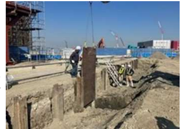
敷鉄板を親杭の間に設置
