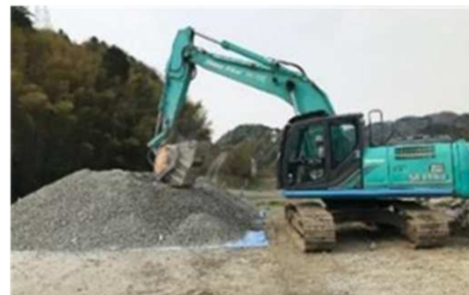
クラッシャーによる破砕処理
