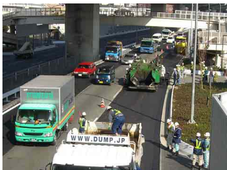
再生排水性舗装の試験施工
