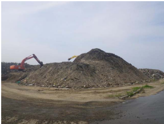
堆積土砂集積状況(分別前)
