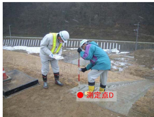
調査状況写真
