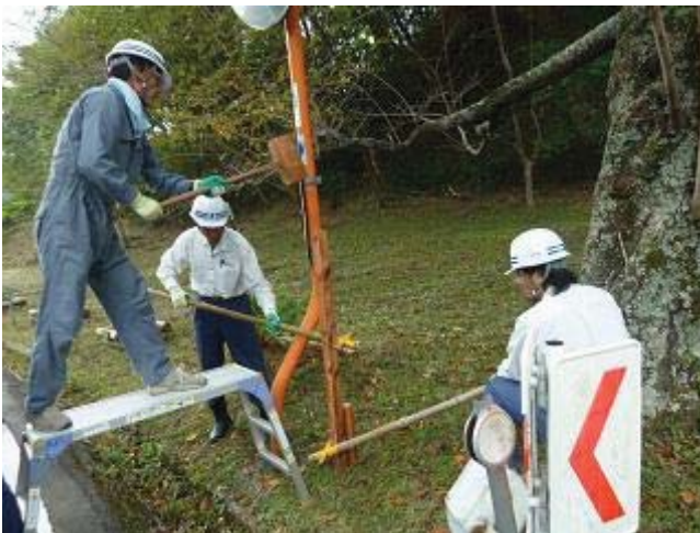
写真-4 キロポスト設置作業
