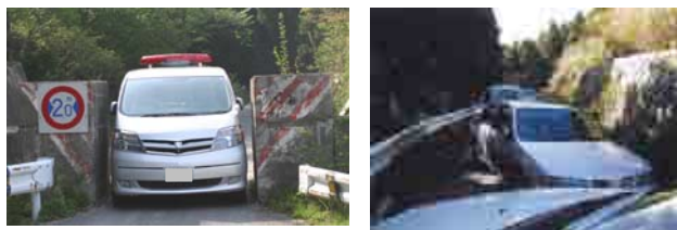
写真-1 トンネル開通前の国道421号
