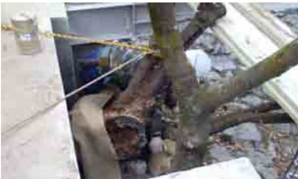
写真-3 根鉢部分施工状況
