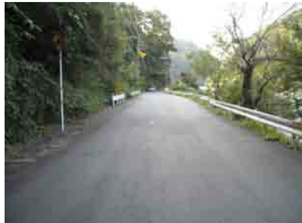
写真-1 左岸工事用道路の工事前
