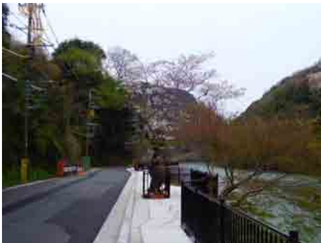
写真-4 組立歩道完成写真
