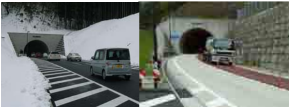
写真2 トンネル開通後の国道421号 (左:滋賀県坑口, 右:三重県坑口)
