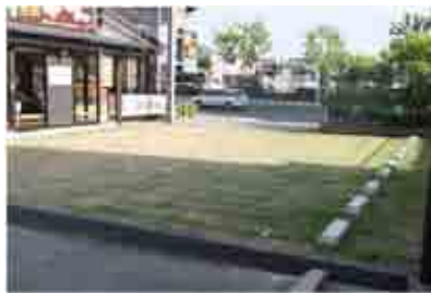
写真-5 緑化駐車場の無償施工
