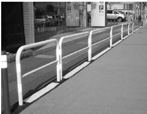
図-4(1) 整備状況写真【横断防止柵】
