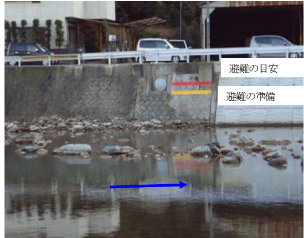
写真-3 避難の目安線状況
