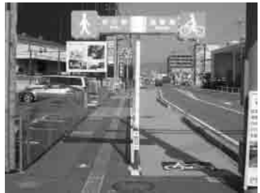
図-4(3) 整備状況写真【案内標識】
