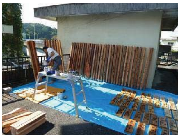
写真-3 ニス塗装作業
