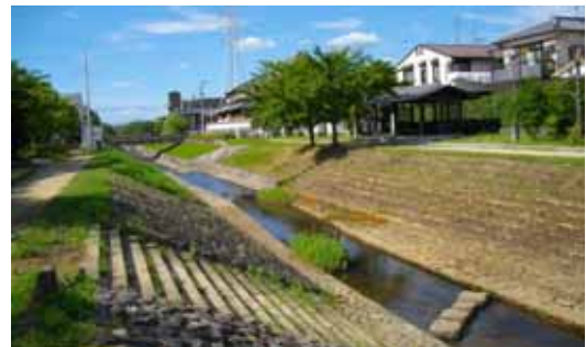
切り下げられた防賀川（現在）
