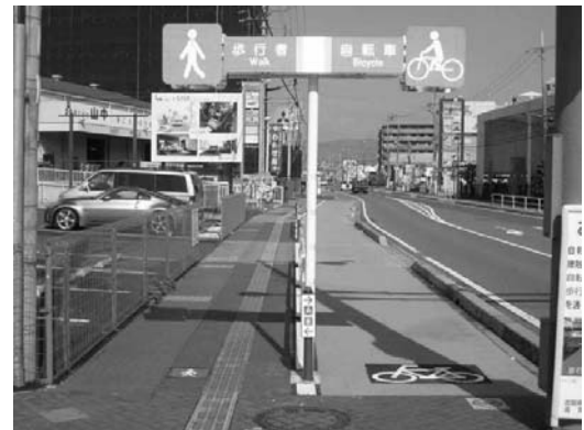
図-4(3) 整備状況写真【案内標識】
