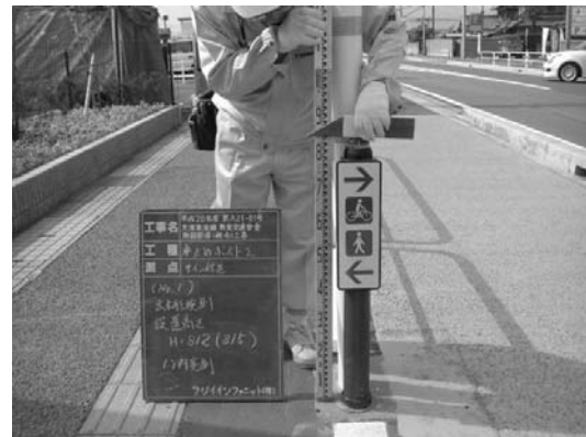
図-4(4) 整備状況写真【車止めポスト】
