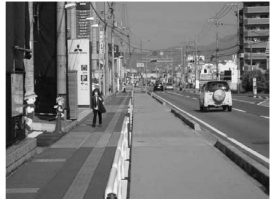
図-4(2) 整備状況写真【路面塗装】
