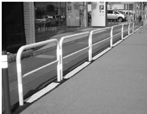
図-4(1) 整備状況写真【横断防止柵】
