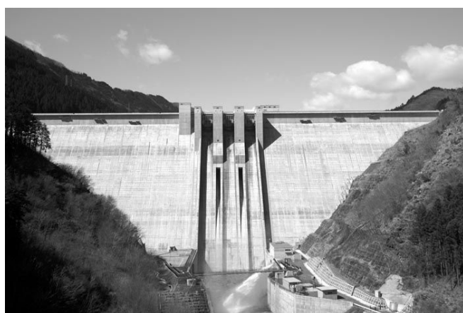
写真-2 堤頂設備の高さを揃えたデザイン (滝沢ダム)
