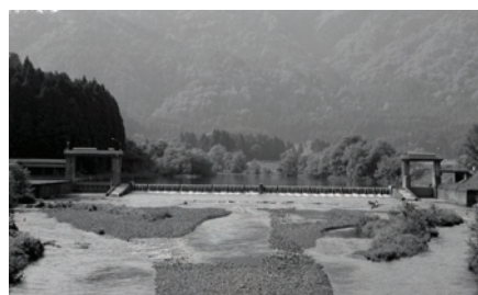
写真-6 現在の高時川頭首工 (2011年5月)
