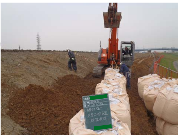
写真6 盛土施工状況
