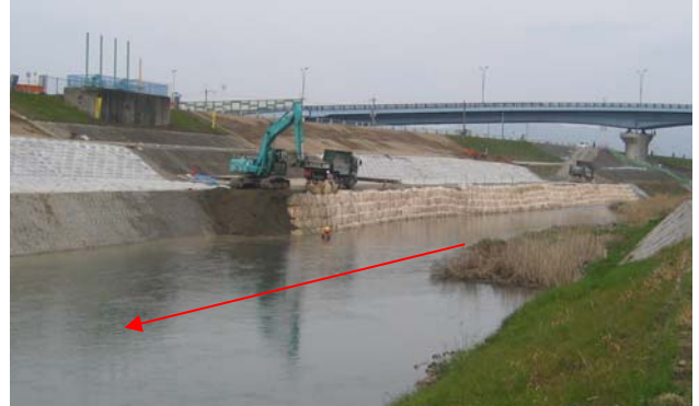
写真5 川表側腹付け盛土のイメージ
