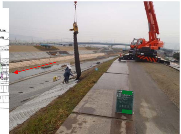
写真7 川裏からの施工状況
