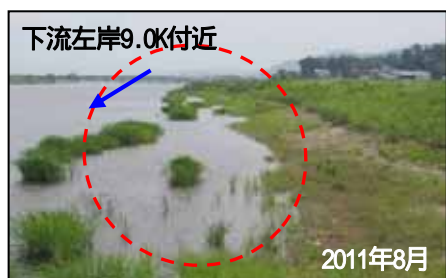
写真-2 水際環境の保全・再生 写真-1左の整備後 (浅場が造成されマコモ群落再生)
