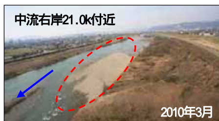
写真-3 砂礫河原の再生 写真-1中の整備後 (樹木伐採やみお筋造成による砂礫河原再生)
