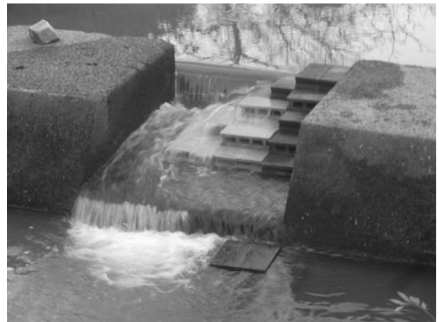
写真-4 オオサンショウウオ道設置状況(階段構造)
