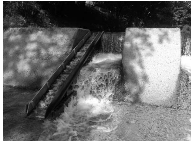
写真-3 オオサンショウウオ道設置状況(斜面構造)
