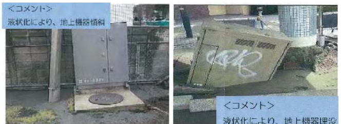
図-1 地上機器の被災状況 2)
