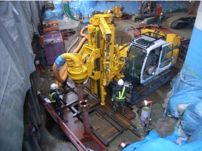
図-7 φ3000 リバース杭 掘削状況
