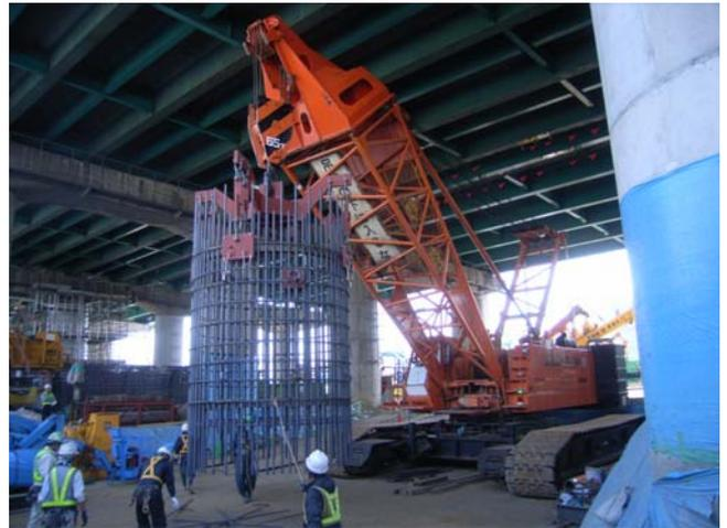
図-8 φ3000 リバース杭 鉄筋建込状況
