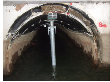
写真2 管渠内部(鉛直方向完了時)
