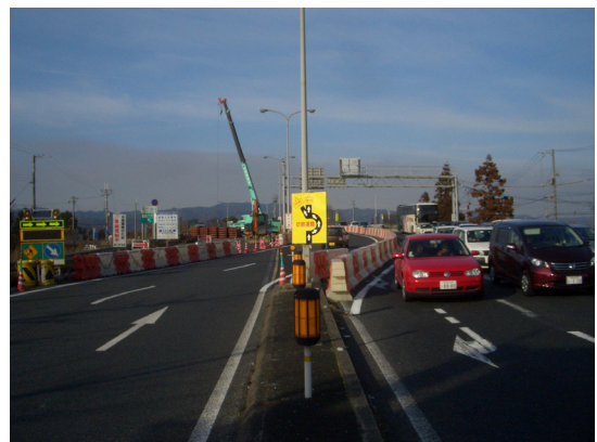
写真3 切り替え（2回目）状況（南側から撮影）
