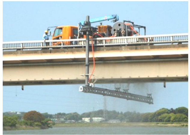
写真-4 橋梁洗浄の状況
