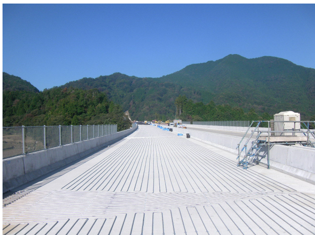
写真2 放熱管施工後
