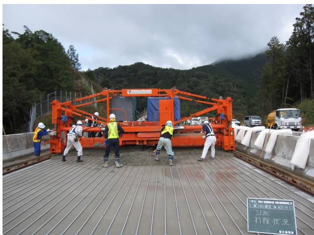
写真3 SFRC施工中
