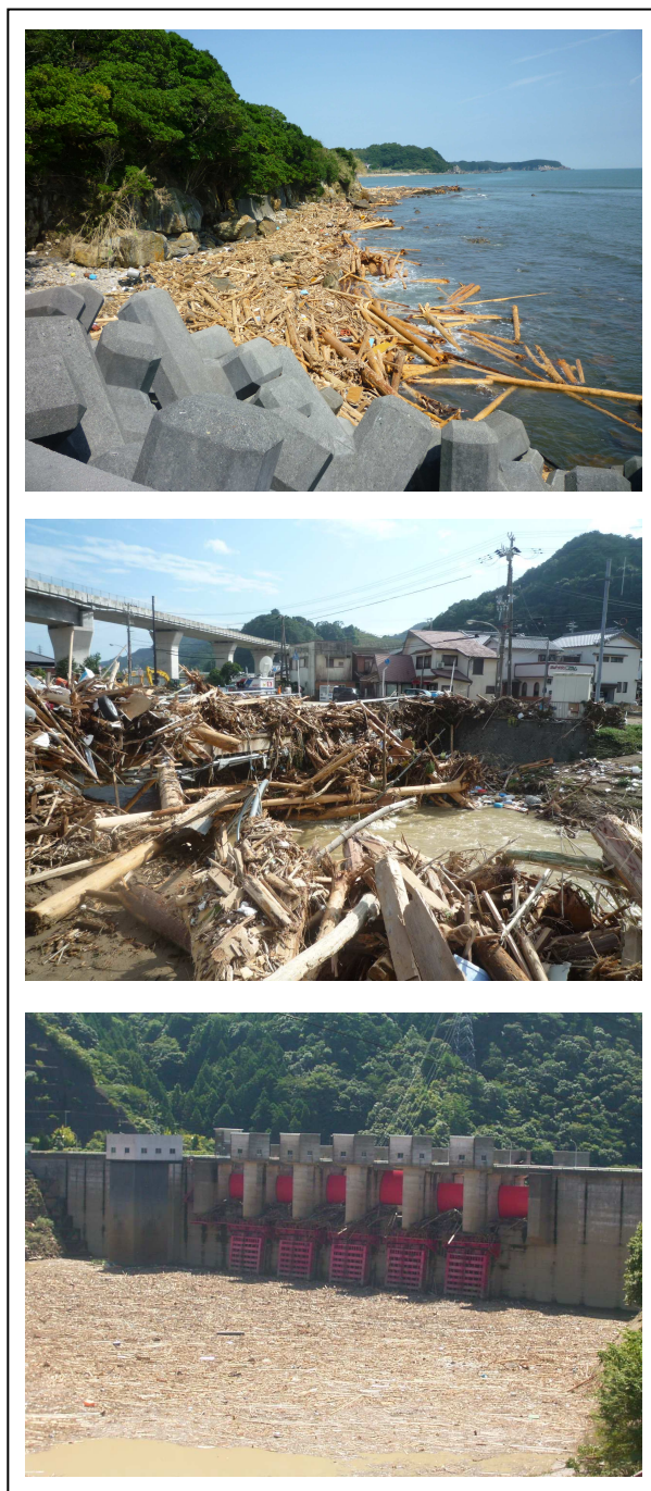
写真-1 海岸・河川・ダムに堆積した流木
