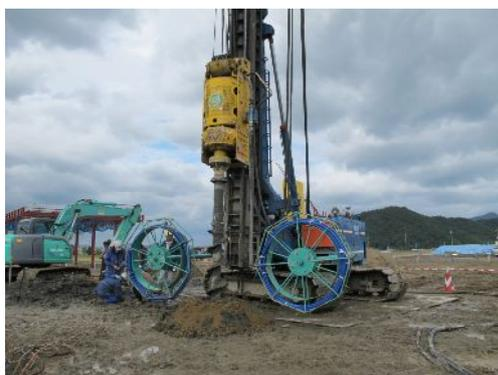
写真-1 スパイラルスクリューによる掘削
