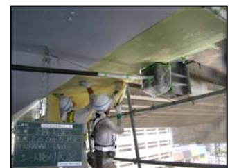
写真-4 断面修復及びメッシュシートによる剥落防止
