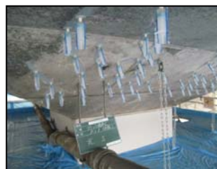
写真-3 乾燥クラックへのエポキシ樹脂注入
