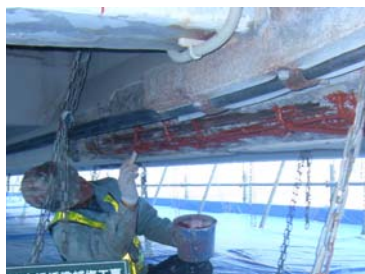
写真-5 PC鋼材素線の破断・補修状況
