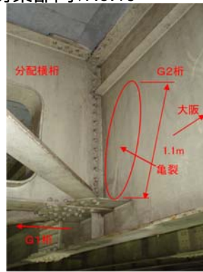
写真-2 主桁ウェブの疲労亀裂と補修状況
